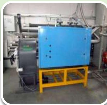
Injecteur de type brûleur ecoHORNET monté sur le boiler diesel Buderus
