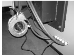
Ventilateur de soufflage
