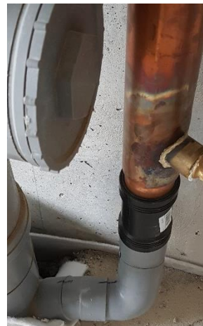
128 Lgts collectifs Parmain (95) Installation mitigeur
