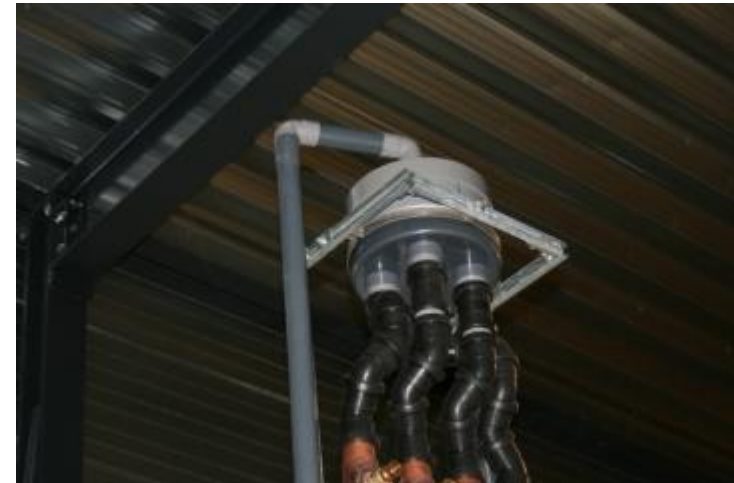
ReQup ® -Plus Multi avec pompe de relevage
